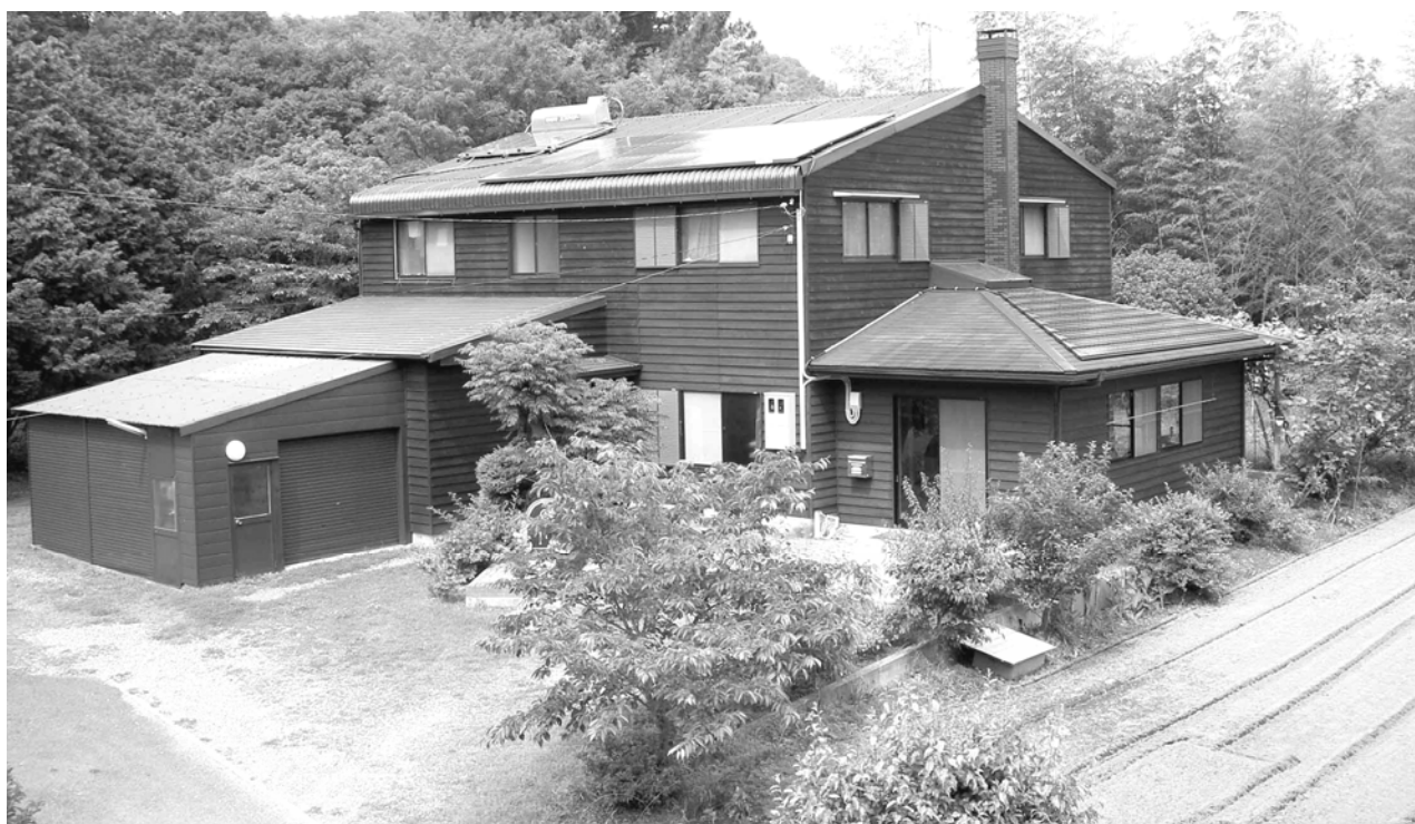
太陽と緑の会月の宮共同生活棟 56枚の太陽光パネルで電力を自給自足しています
