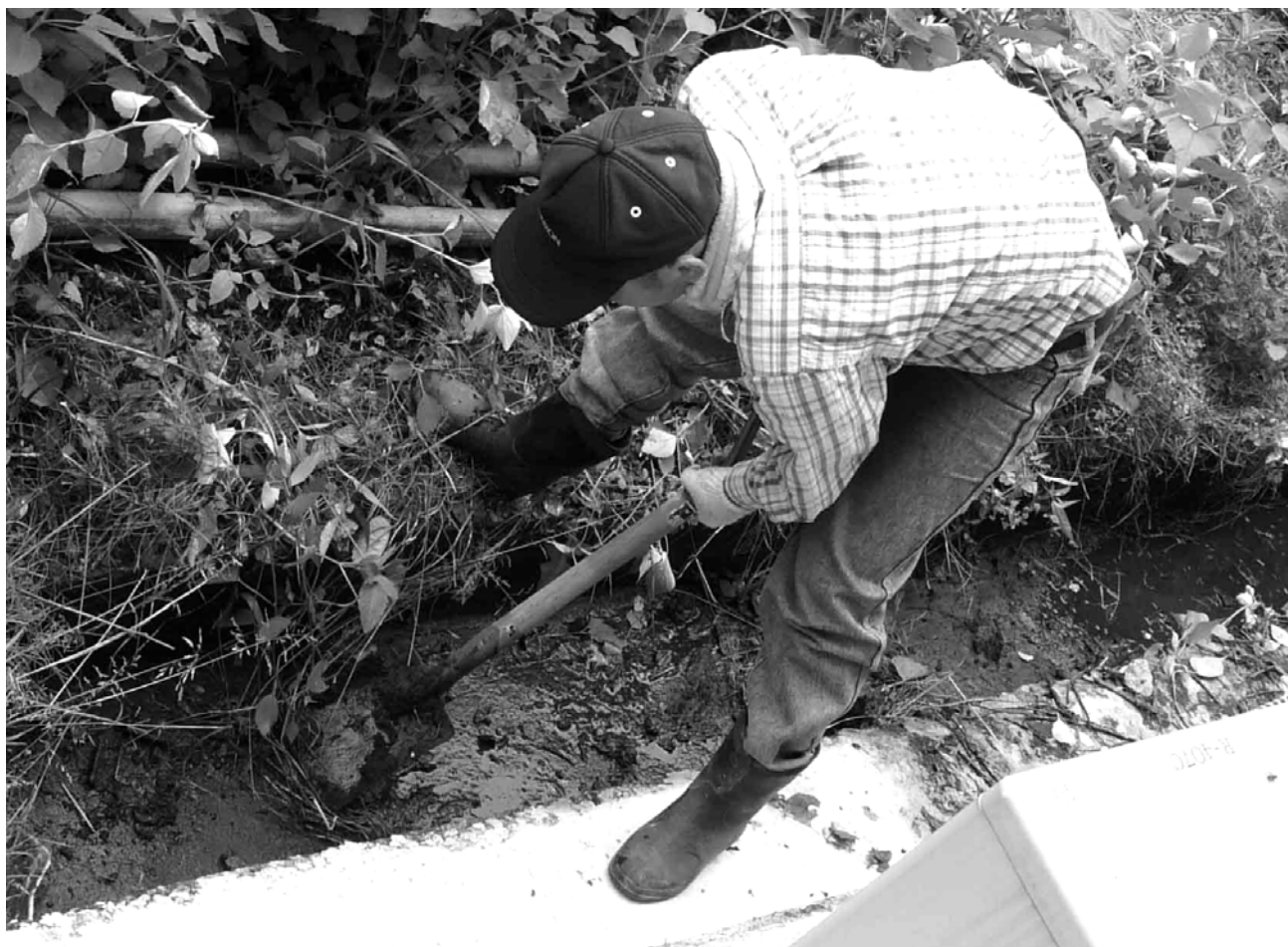
新館裏の排水路の清掃
