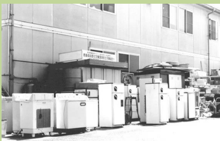
写真で見る 30 年⑥ 太陽と緑の会事務局・作業所兼店舗建物
