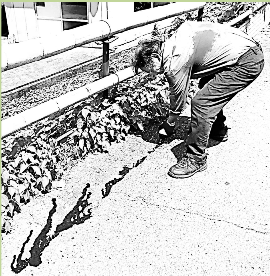
アスファルト路面の補修(当会代表杉浦)
